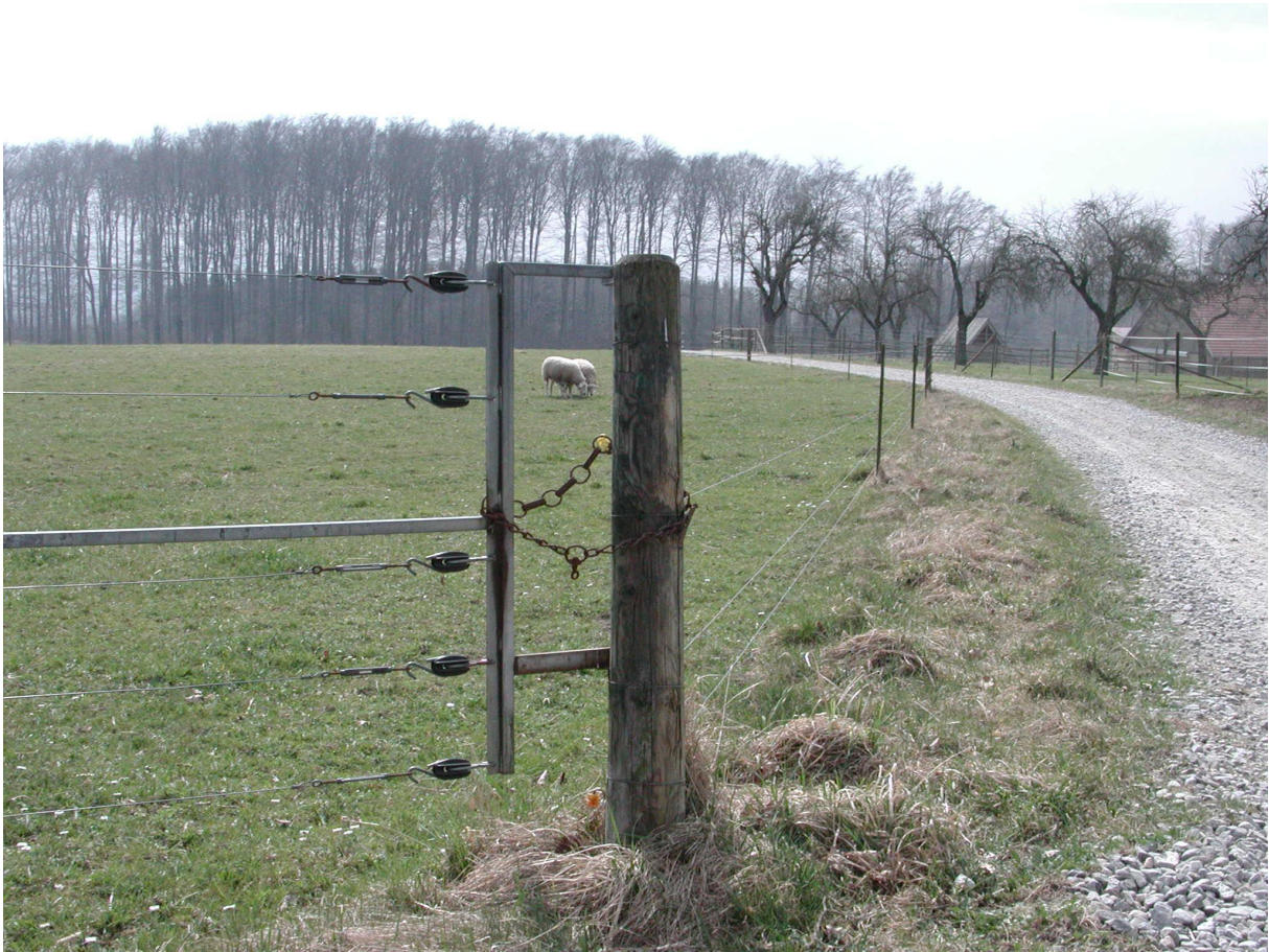
Elektrifiziertes Tor. Es kann durch ein Vorhängeschloss gegen unbefugten Zutritt gesichert werden
